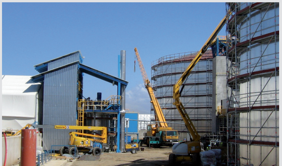
Der Schmelzofen im Aufbau mit beiden Flüssigsalztanks, die als Wärmespeicher dienen.
